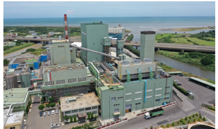
汽電共生廠俯瞰圖
