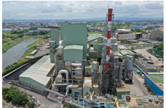
汽電共生廠俯瞰圖
